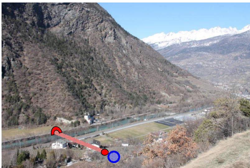
Abbildung 50: Bereich Ende Abschnitt 5 mit dem Tunnelportal, der Vispaquerung und dem Muffenstandort
