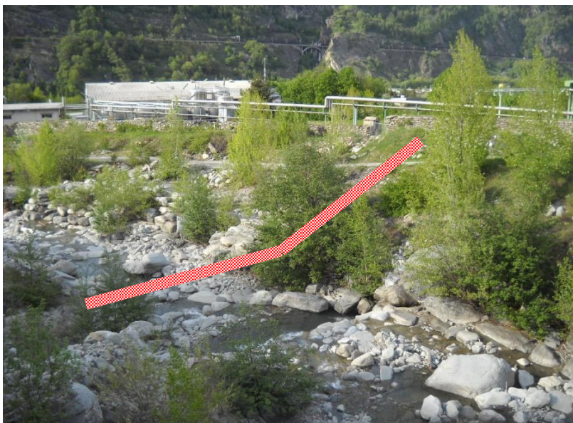
Abbildung 64: Querung Gamsa mittels Mikrotunneling
