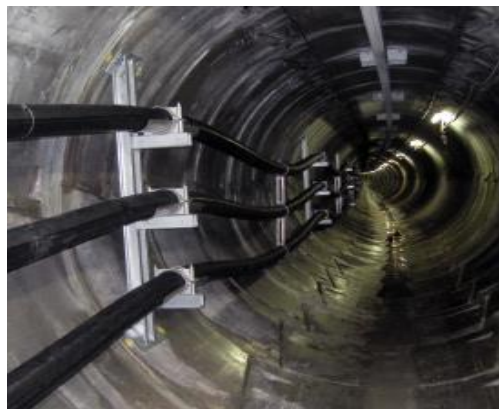
Abbildung 6: Kabeltragelemente (Quelle: nkt cables, Referenzen / Beddington, London, 2016)
