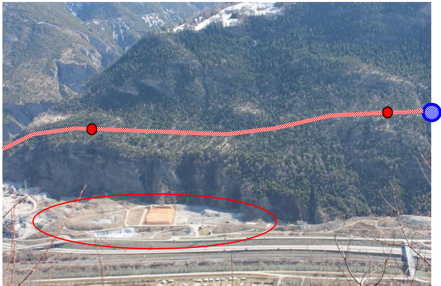
Abbildung 62: Trasseeführung oberhalb der Lonzadeponie (rot umkreist) mit Abstieg zur Gamsa
